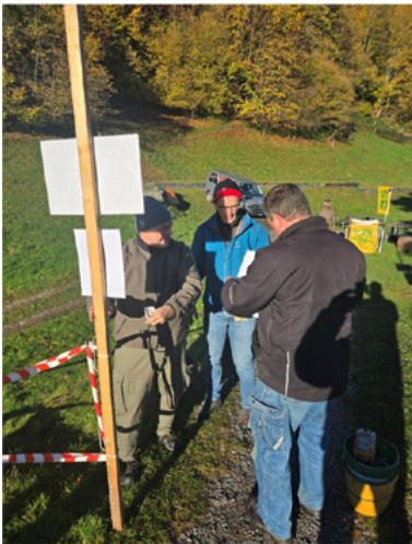
Auch die Beschilderung/Wegweiser werden fachmännisch montiert.
