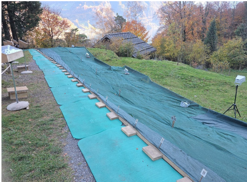
Auch im Schiessstand schreiten die Arbeiten voran. Der Teppich ist bereits ausgelegt.
